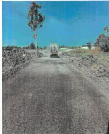
ภาพที่ 2.2-3 ฉีดพรมพื้นที่ก่อสร้าง
